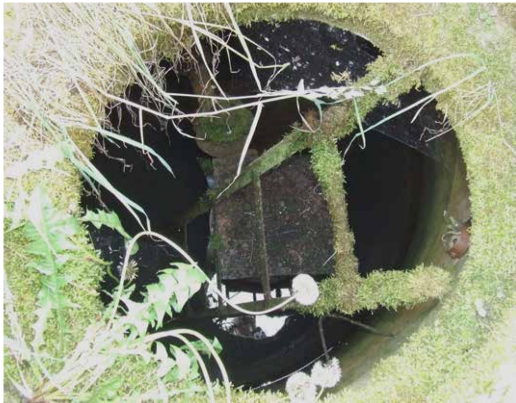
Korrast ära kaev.
